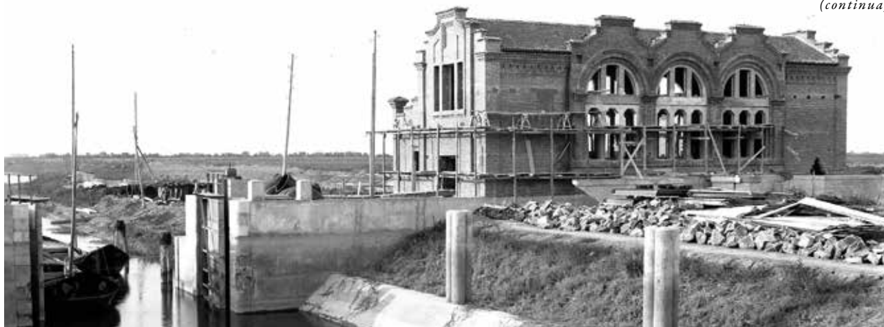
IMPIANTO IDROVORO DI TORRE DI FINE IN COSTRUZIONE (1925). ARCHIVIO FOTOGRAFICO MUB - MUSEO DELLA BONIFICA
